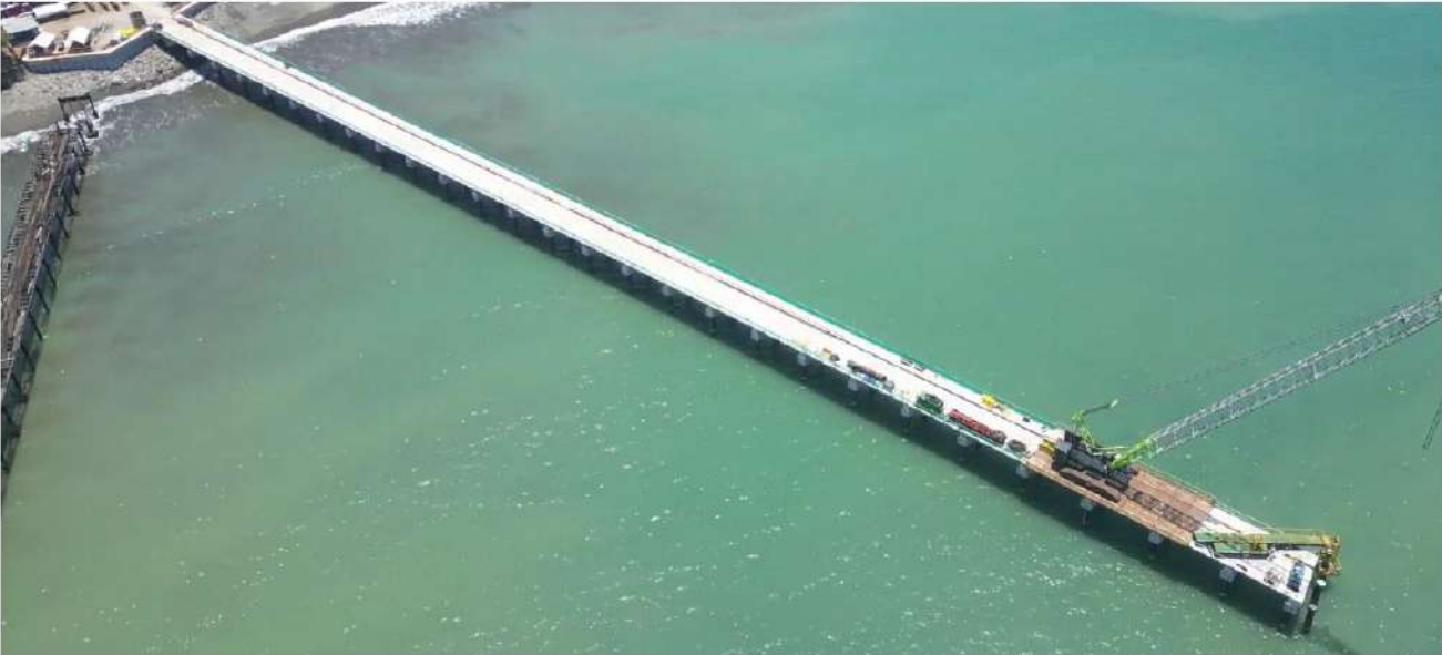
* Avances en la construcción de Puerto Armuelles.
