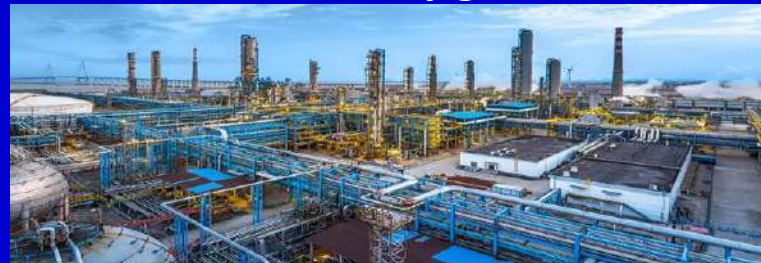
Refinería Repsol, Sines - España
