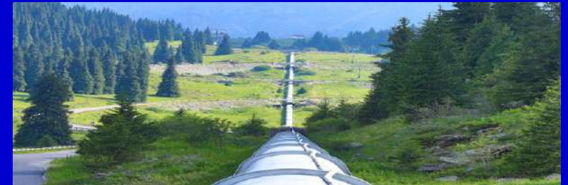
Tuberías y conducción – Perú
