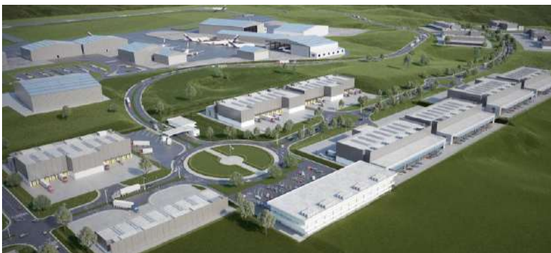
Zona Logística del Aeropuerto Internacional de Tocumen - ZLAT
